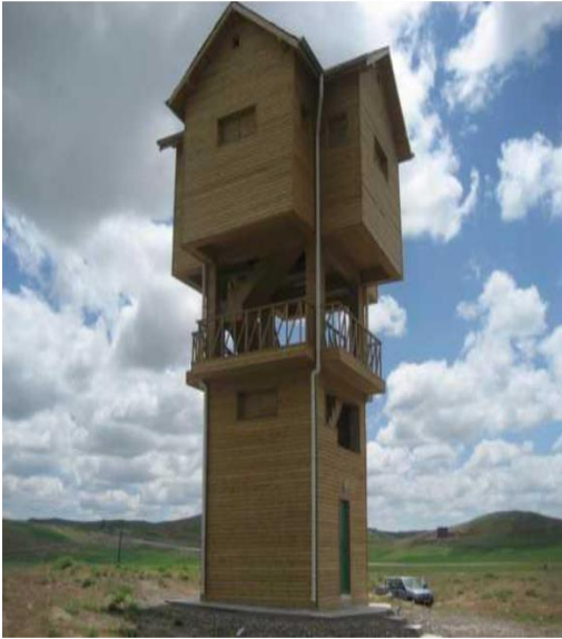
Kuş gözlem kulesi
