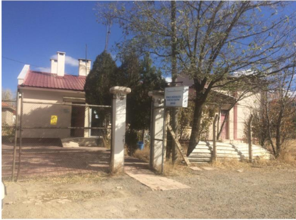
FOTOĞRAF 23: Çamlıbel Elektrik Dağıtım Aş Ulaş İlçe İşletme Şefliği
