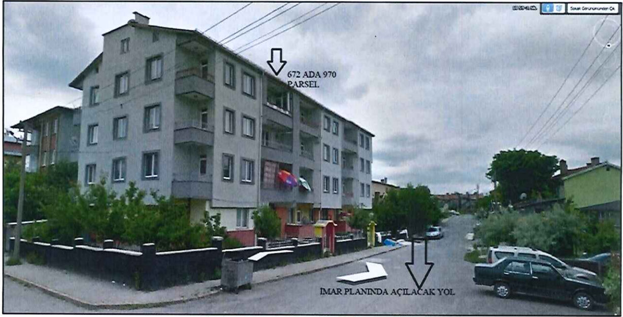
Şekil 12:672 Ada 970 Parselde ki Binaın Görüntüsü
