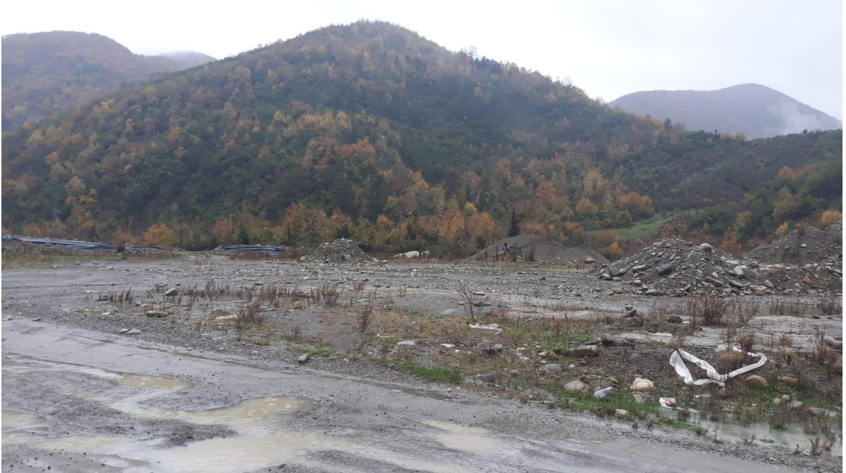
Şekil : 52 Sinop Ayancık İlçesi Ayancık Çayı eski vahşi depolama alanı düzenleme resim
