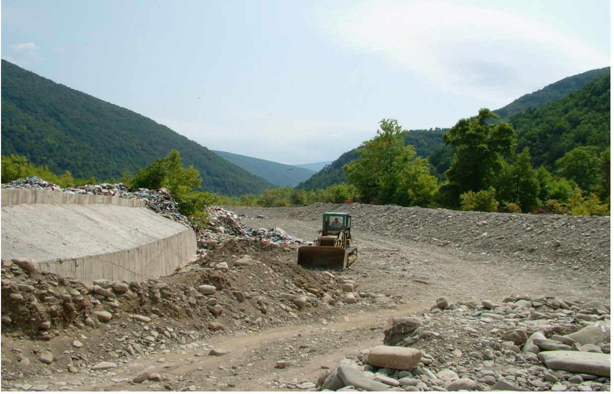
Şekil : 51 Sinop Ayancık İlçesi Ayancık Çayı eski vahşi depolama alanı düzenleme resim
