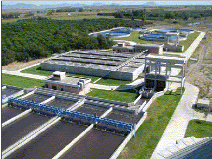
Şekil 3-11 Doğu Adana Atıksu Arıtma Tesisi Genel Görünüm
