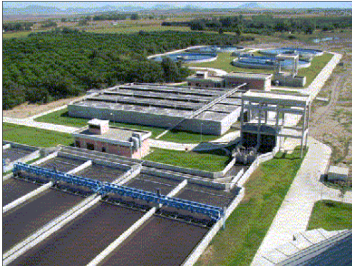
Şekil 3-13 Doğu Adana Atıksu Arıtma Tesisi Genel Görünüm
