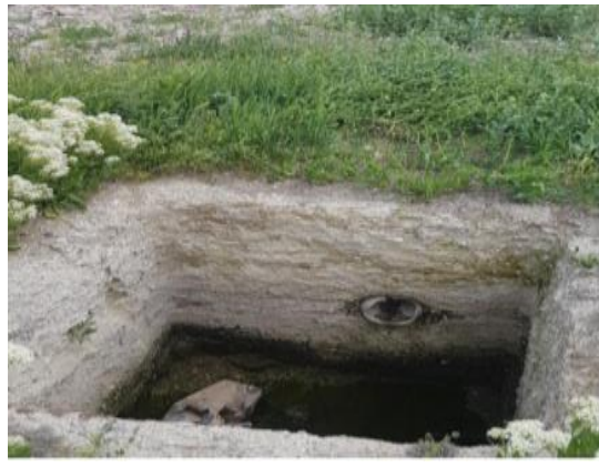
Fotoğraf 14: Silaj Sızıntı Havuzu Örneği Fotoğraf: H.Varol
