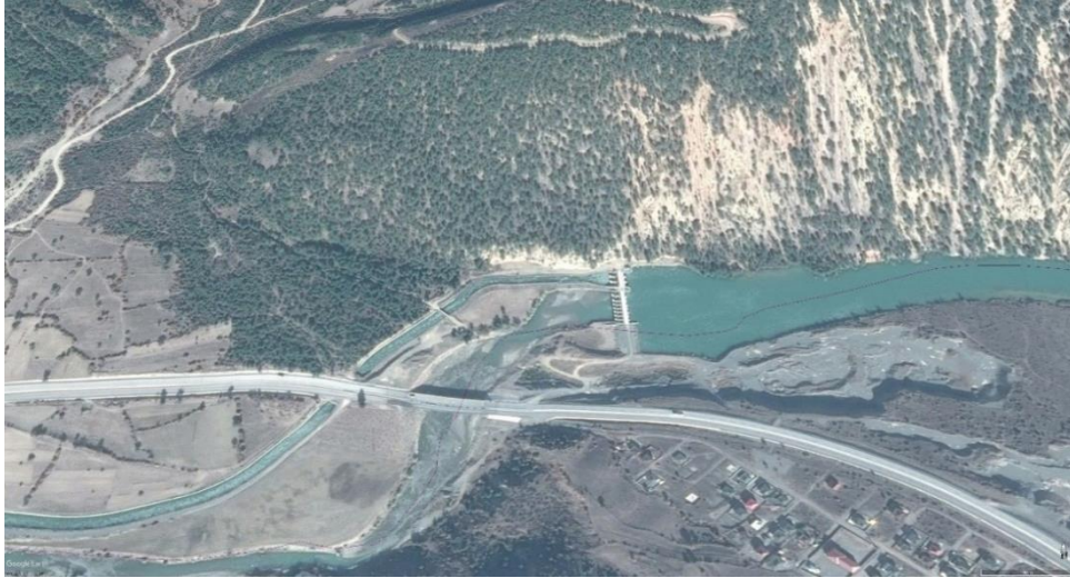
Şekil 74. Akış Düzenleme Baskısı Örneği (Hidroelektrik), Yeşilirmak Havzası
