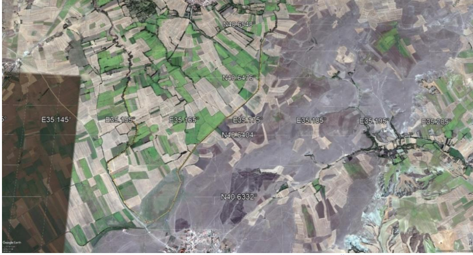
Şekil 73. Salhan Çayının Düzleştirilmesi ve Kanal Haline Getirilmesi Örneği, Yeşilirmak Havzası
