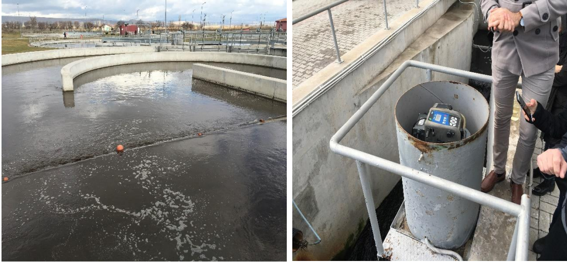
Şekil 17. Afyon Merkez AAT ve Atıksu İzleme İstasyonu
