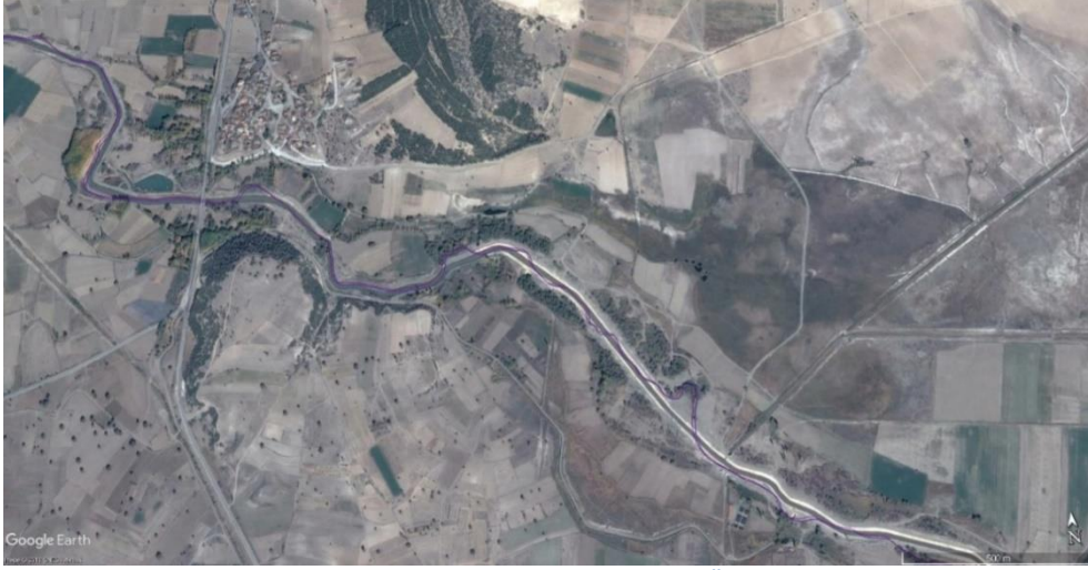
Şekil 45. Nehir Yatağı ve Kıyı Koruma Tahkimatı Baskısı Örneği, Batı Akdeniz Havzası
