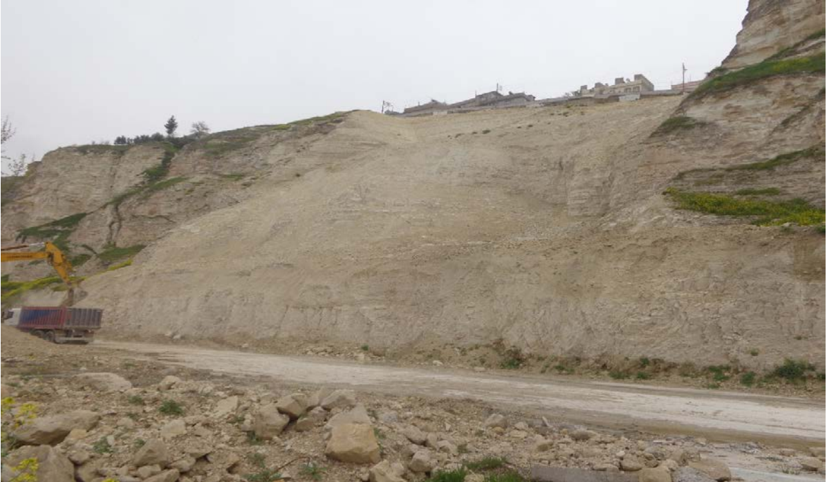
Resim 3: Birecik Kaya Düşmesi Olayından Sonra Yamacın Islah Edilmiş Hali
