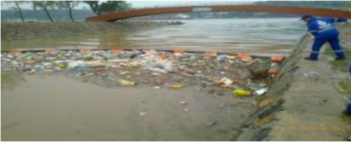
Şekil 4.1. Dere/Nehir Ağı Temizliği Örnek Çalışma
