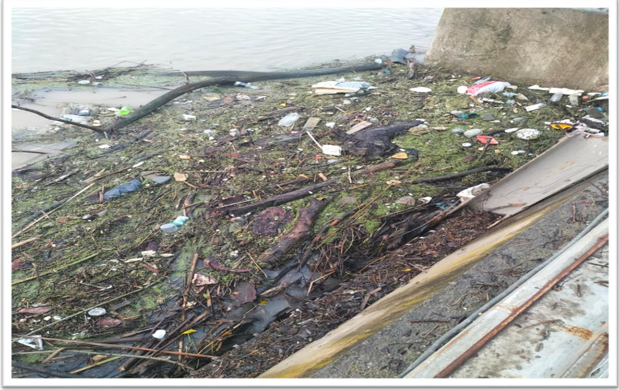
Şekil 34: Hidroelektrik Santrallerde Biriken Deniz Çöpleri
