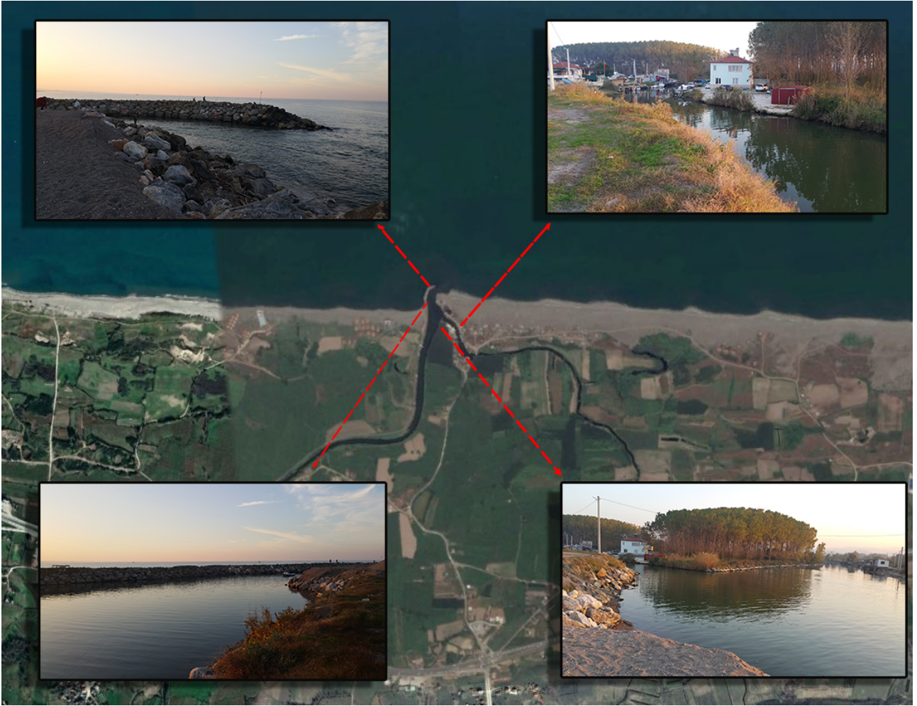
Şekil 5. Proje Sahasının Mevcut Durumu
