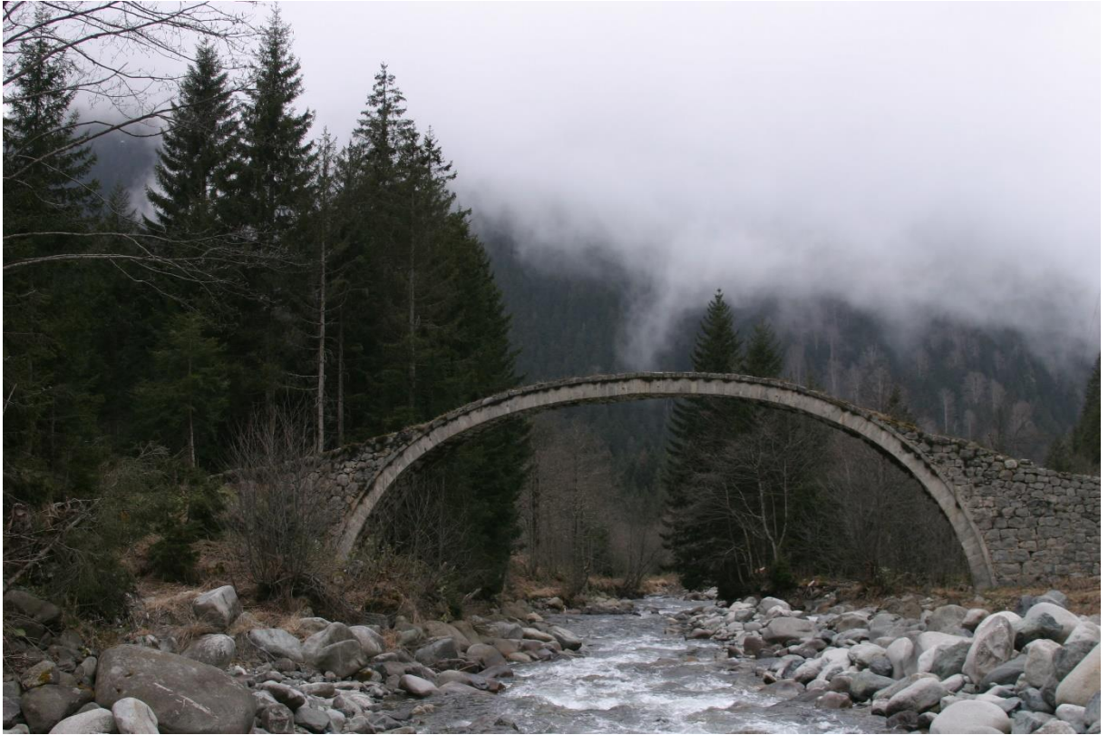
Çat (Çılanç) Köprüsü
