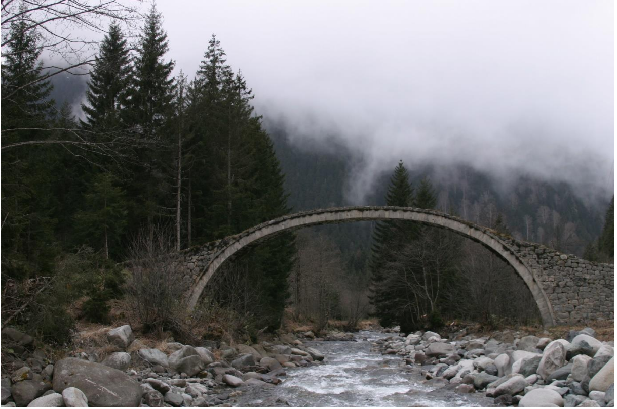
Resim 1- Çat (Çılanç) Köprüsü
