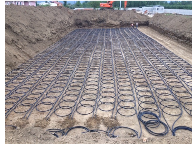
Villa Projesi / Düzce 32 slinky hattı / 150 kW – Serme
