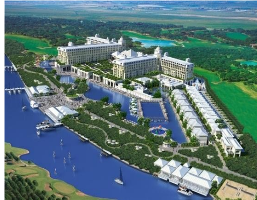
Antalya Otel Nehir suyu kaynaklı
