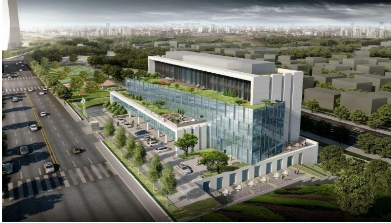
Kamu Binası / İstanbul 150 kW- Sondaj 3000 metre
