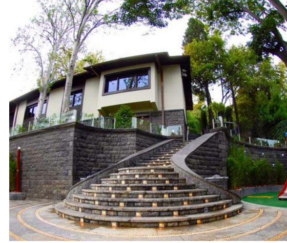
Villa / İstanbul 80 kW- 7 kuyu-Sondaj 1200 metre
