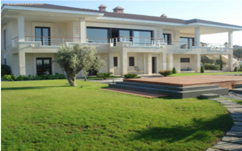
Villa Projesi / İzmir Toprak Kaynaklı Uygulama – Sondaj
