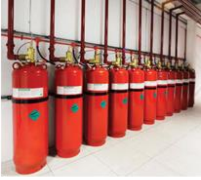
Şekil 4. Novec 1230™ kullanılan fiskeye sulama sistemleri
