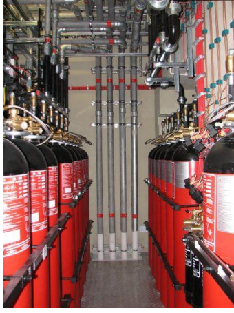
Őekil 9. Yangın sndrme ajanı olarak Inergen TM kullanan, fiske sulama yangın sndrme sistemleri
