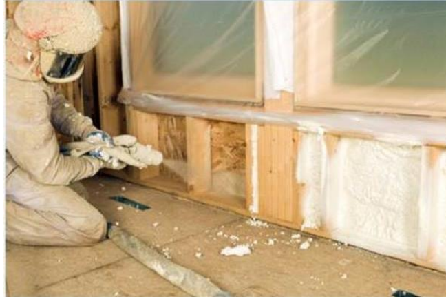
Şekil 8 Duvarların Forane™ FBA 1233zd ile doldurulmuş PUR köpüğü ile yalıtılması süreci
