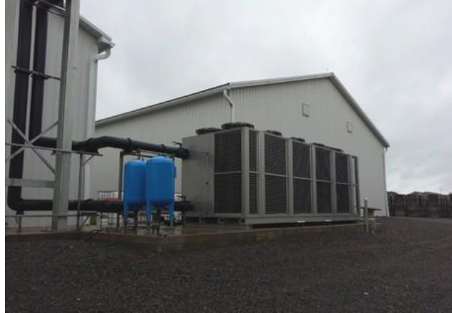
Şekil 8: HC soğutucusu kullanan doğrudan olmayan sistem.
