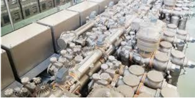
Şekil 9. Şekil 8.'da gösterilen pilot trafo merkezinde kurulu 170 kV HV GIS ve 24 kV MV GIS ekipmanlarının fotoğrafları
