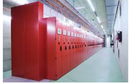
Şekil 9. Şekil 8.'da gösterilen pilot trafo merkezinde kurulu 170 kV HV GIS ve 24 kV MV GIS ekipmanlarının fotoğrafları
