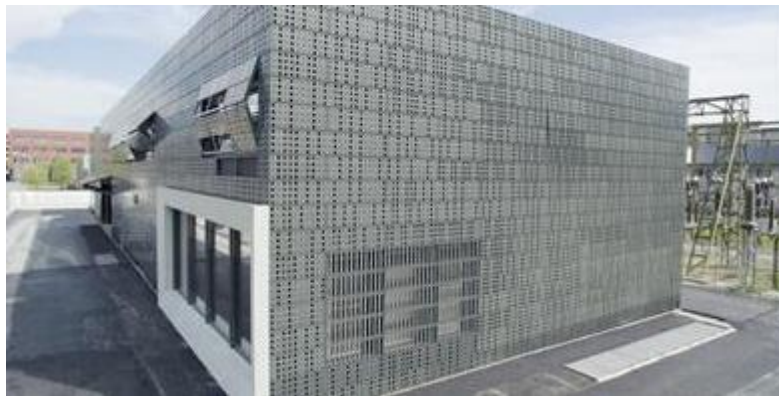
Şekil 8. Oerlikon (İsviçre)'de Novec 5110™ içeren ABB tescilli yalıtım gazı karışımı kullanan HV GIS 170 kV ve MV 24 kV ekipmanları kurulu pilot trafo merkezi
