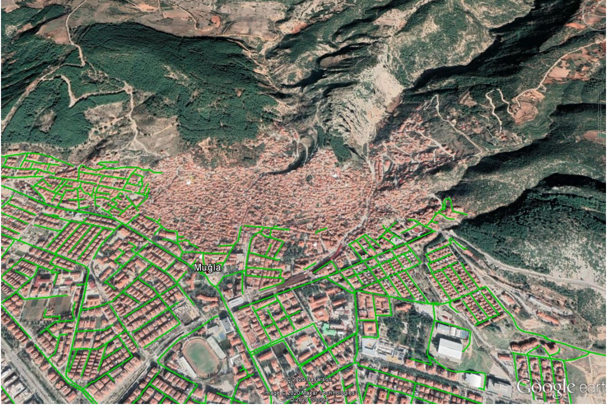
Şekil 26: Muğla Mentеше İlçesi Doğalgaz Hattı Güzegahı 3
