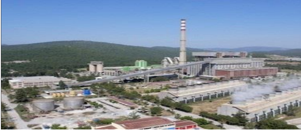
Şekil 22: Yeniköy Termik Santrali
