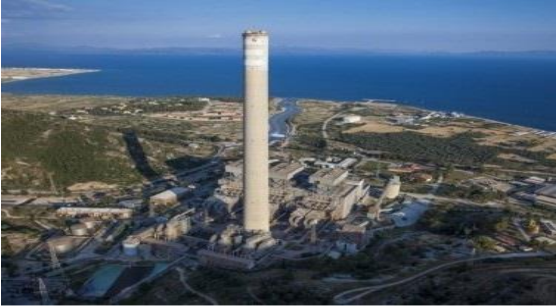
Şekil 23: Kemerköy Termik Santrali
