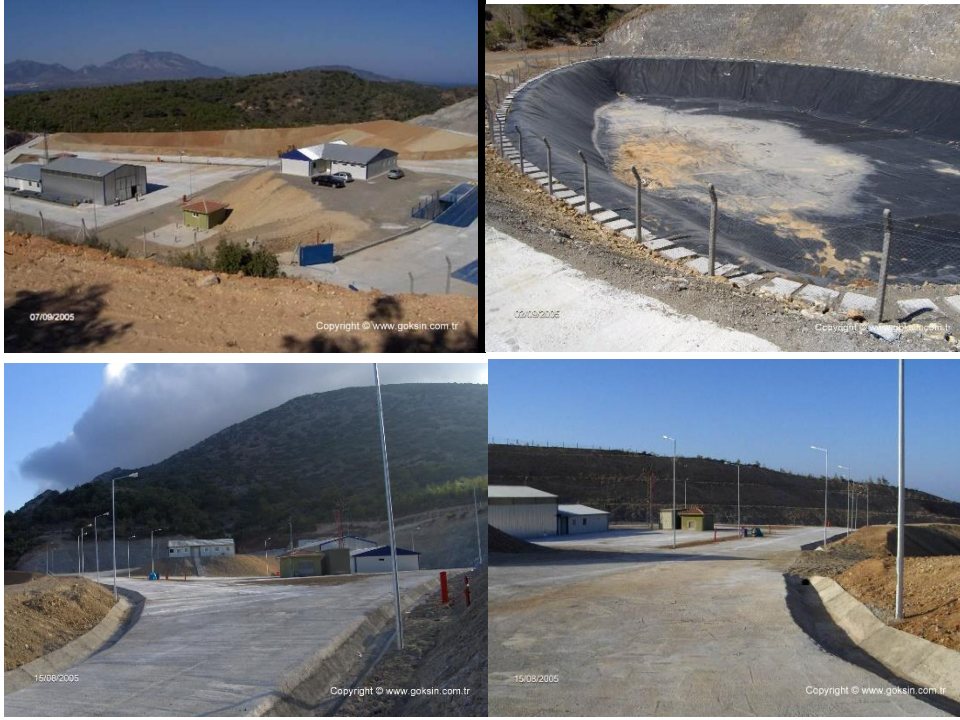
Şekil 3: Datça Katı Atık Düzenli Depolama Sahası
