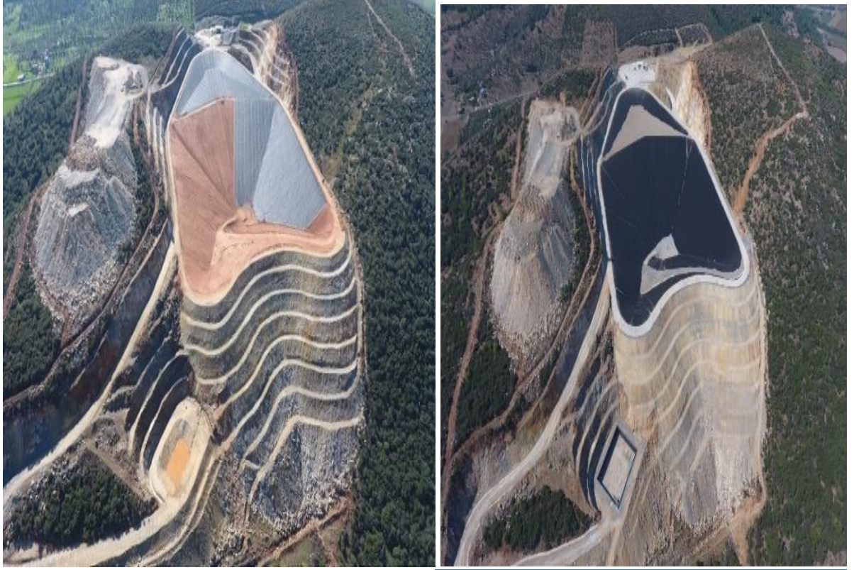
Şekil 5: Milas Katı Atık Düzenli Depolama Sahası
