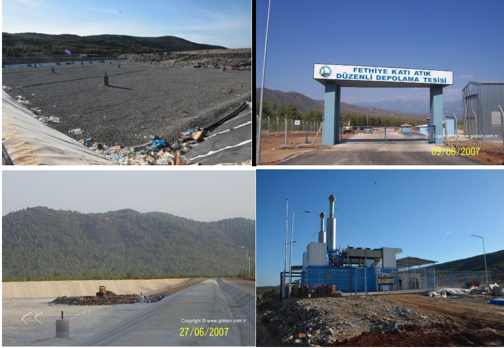
Şekil 4: Fethiye Katı Atık Düzenli Depolama Sahası
