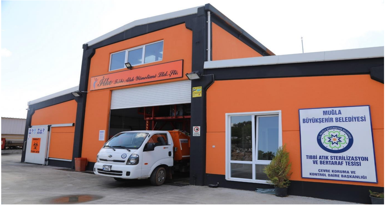
Şekil 9: Muğla Büyükşehir Belediyesi Tıbbi Atık Sterilizasyon Tesisi
