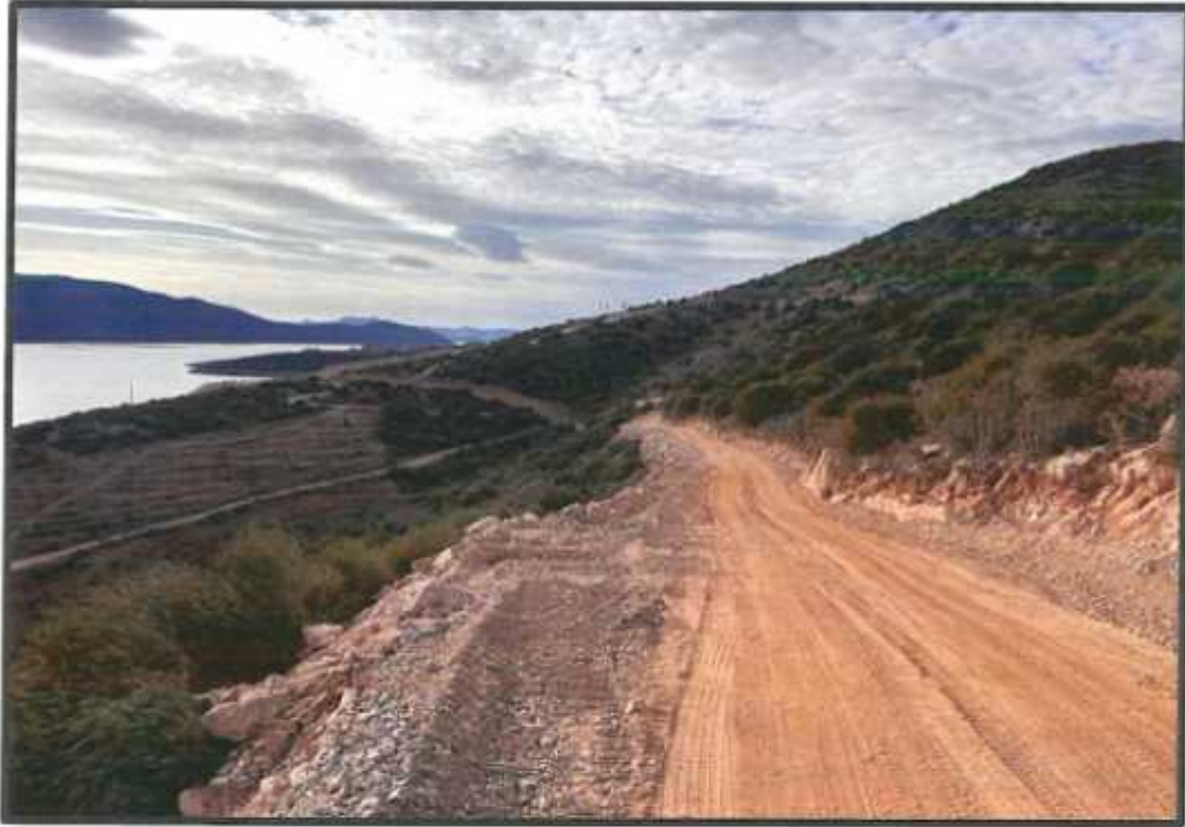
F.25. Planlama Alanında Bulunan Yol
