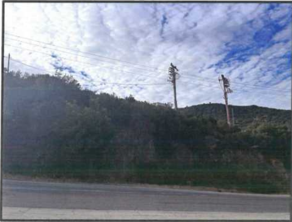
F.22. Planlama Alanında Bulunan Yol
