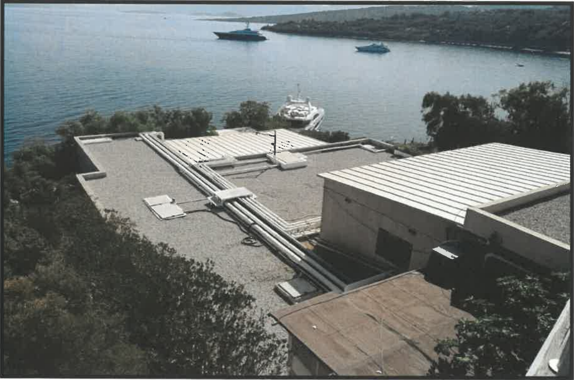
FOTOĞRAF-14 (Aritma Tesisi)
