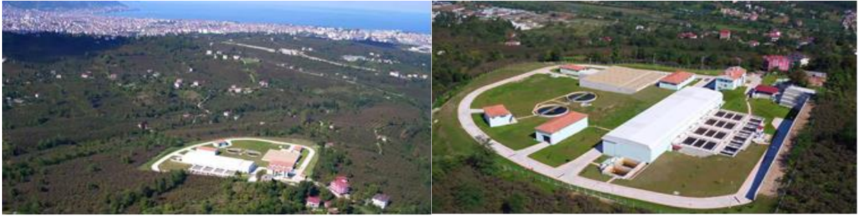
Şekil 23: Ordu İçme suyu Arıtma Tesisi Görüntüleri
