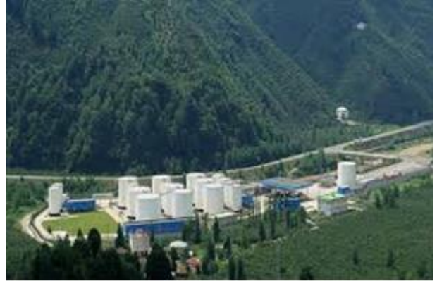
Trabzon POAŞ Tesisleri
