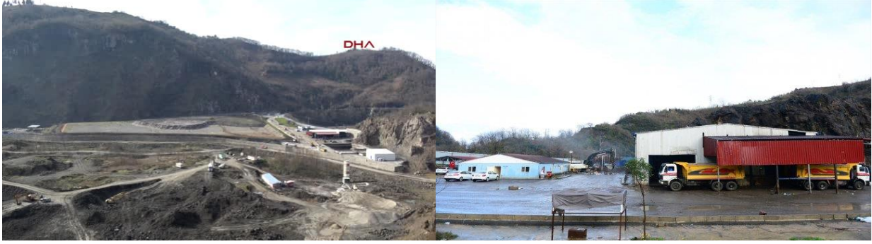
Şekil 47: Çavuşlu Düzenli Katı Atık Depolama Tesisi Görüntüleri.
