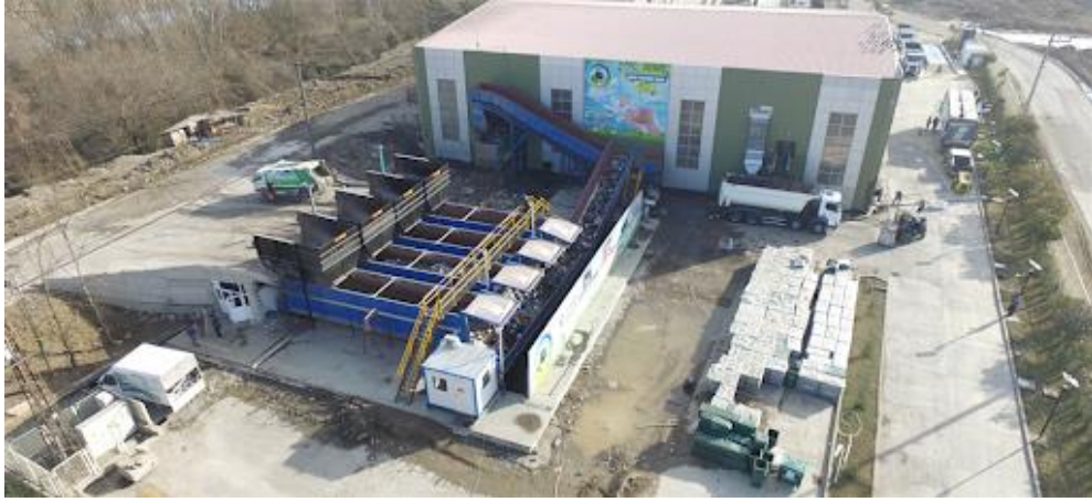
Şekil 45: Ünye Katı Atık Ayrıştırma Tesis Görüntüsü
