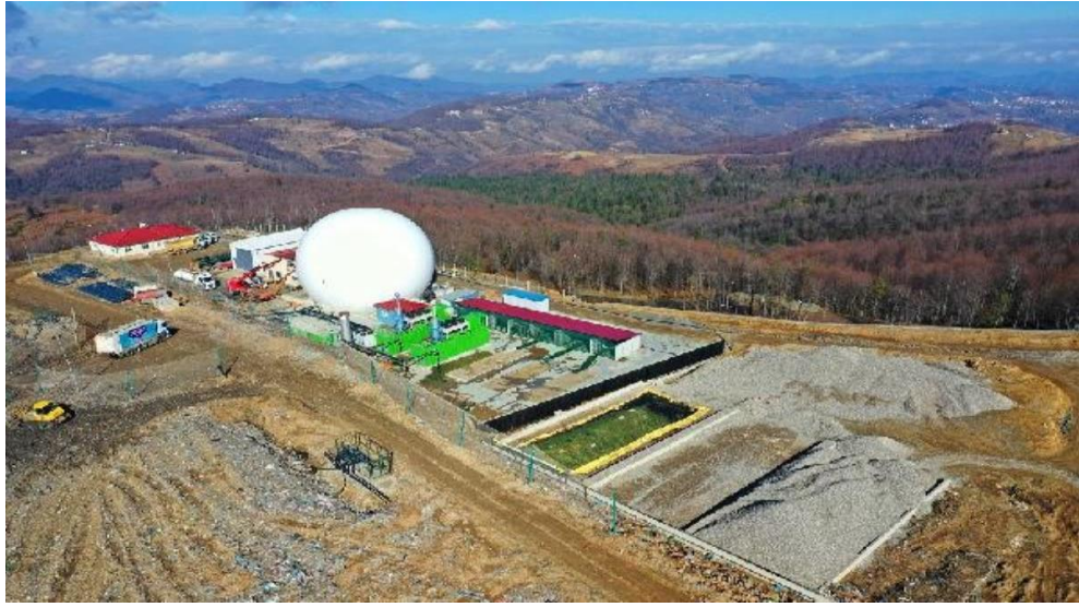
Şekil 46: Çaybaşı ilçesinde bulunan Katı Atık Düzenli Depolama Tesisi ve Enerji Üretim Tesisi
