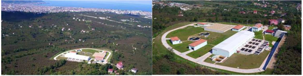
Şekil 23: Ordu İçme suyu Arıtma Tesisi Görüntüleri
