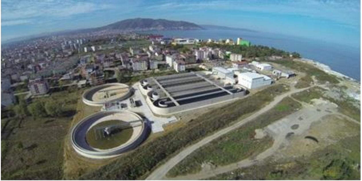
Şekil 30: Ordu Atıksu Arıtma Tesisi Görüntüsü
