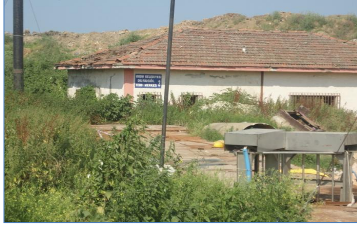
Şekil 31: Ordu Merkezde Yer Alan Atıksu Arıtma Tesisleri
