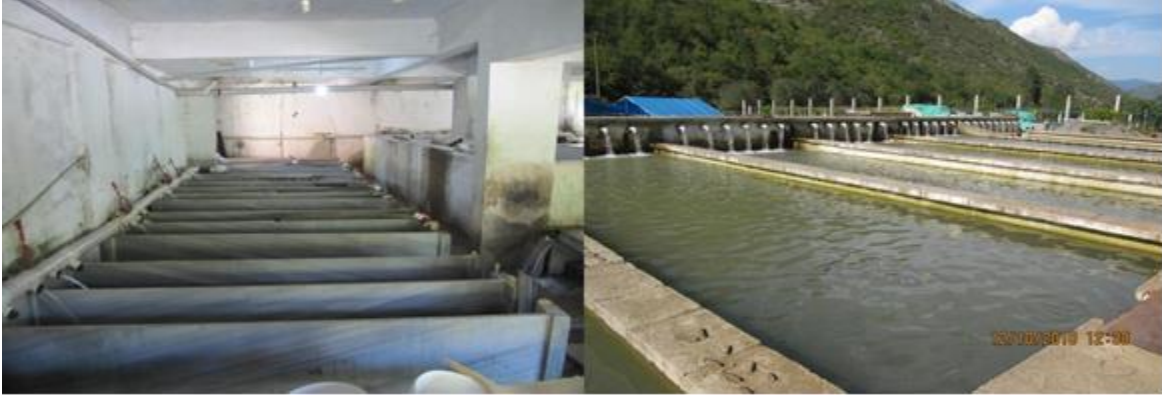
Şekil 59: Dikdörtgen Beton Büyütme Havuzu ve Mermer Yavru Yalakları (DOKA, 2012)
