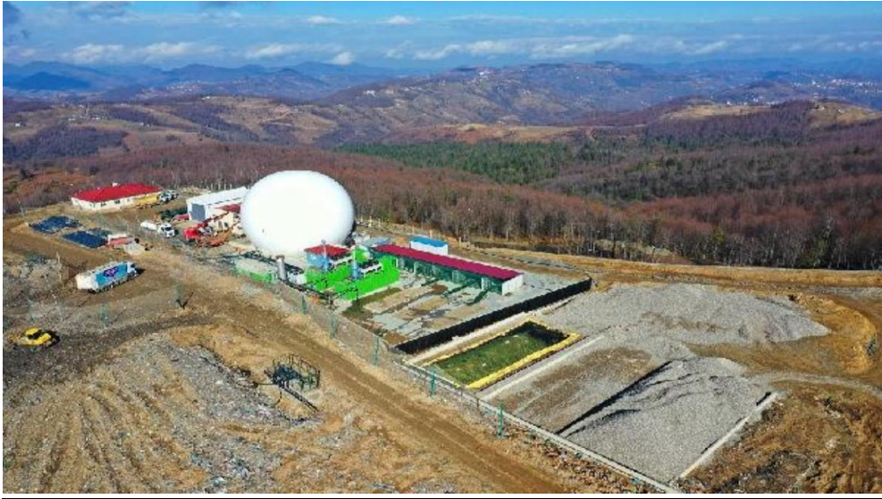
Şekil 46: Çaybaşı ilçesinde bulunan Katı Atık Düzenli Depolama Tesisi ve Enerji Üretim Tesisi
