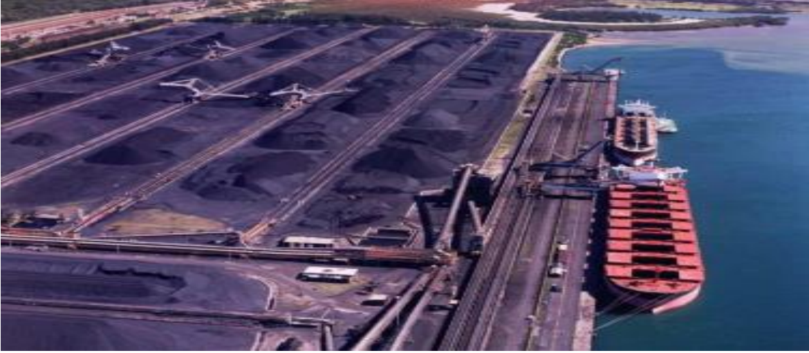
Şekil 37. Lineer bir rıhtımda kuru yük elleçlemesi (boşaltma)
