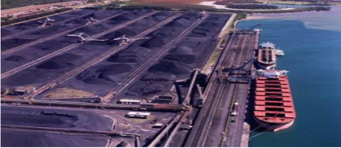
Şekil 153. Lineer bir rıhtımda kuru yük elleçlemesi (boşaltma)
