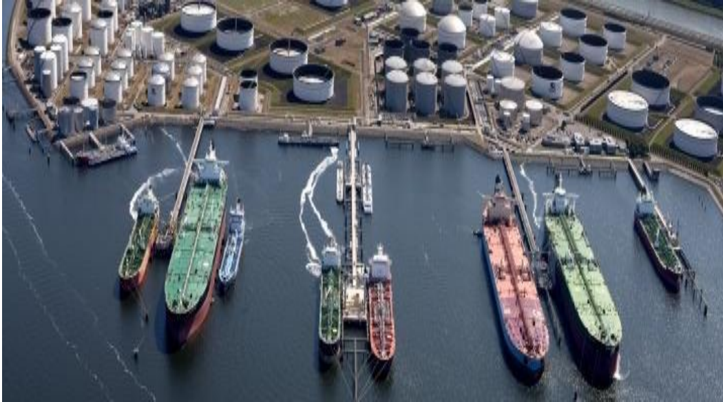
Şekil 152. İskele platforma bağlı kuru yük elleçlemesi (yükleme)
