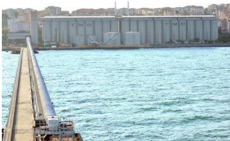
Şekil 37. Tekirdağ TMO İskelesinden bir görünüm 80
