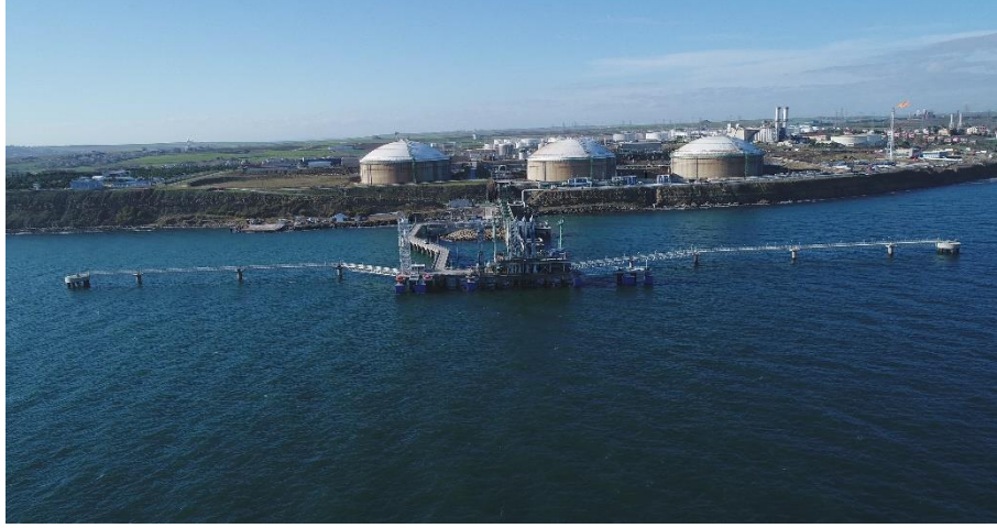
Şekil 35. Marmara Ereğlisi LNG Terminalinden bir görünüm 76
