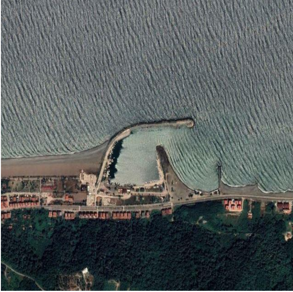
Şekil 78. Abana Balıkçı Barınağı
