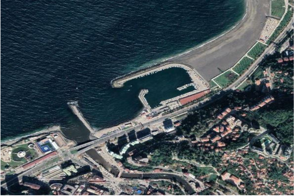
Şekil 21. Kozlu Balıkçı Barınağı
