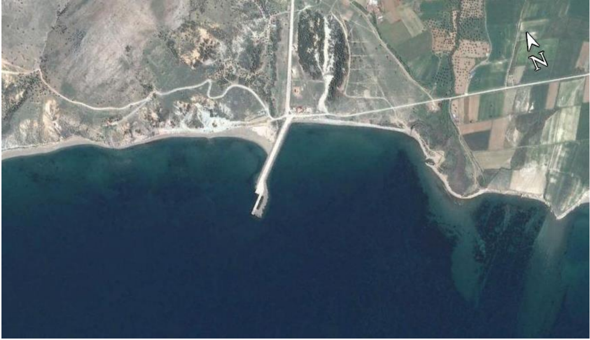
Şekil 21. Uğurlu İskelesi, Uydu Görüntüsü Kuzu Limanı Feribot İskelesi
