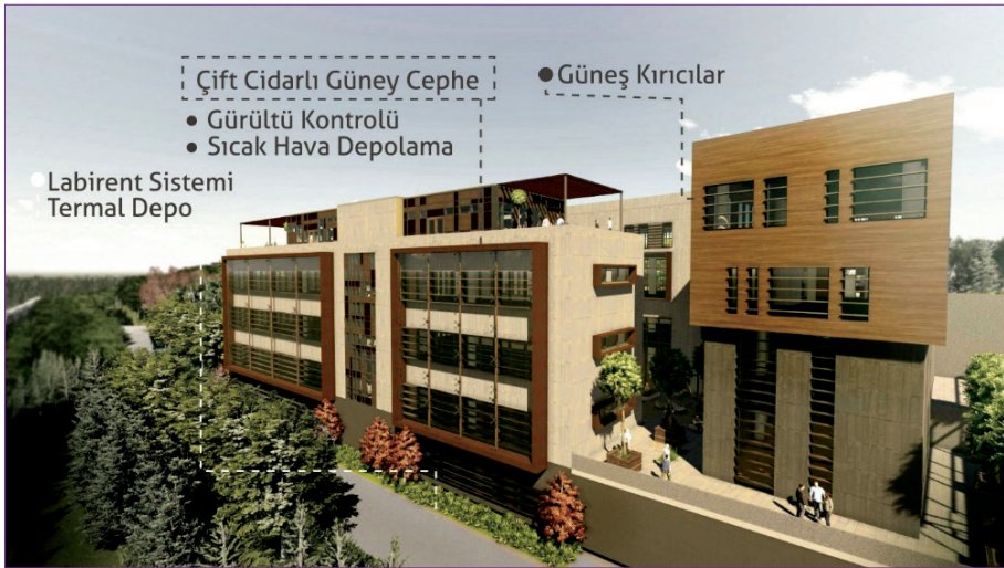
Şekil 4. Güney cephe ve çift cidar uygulaması
