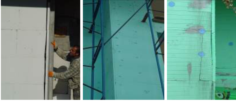
Şekil 13. Yanlış levha kenetleme örnekleri
