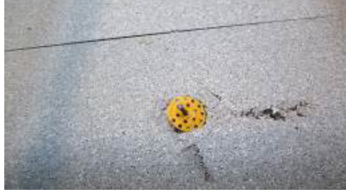
Şekil 19. Hatalı matkap kullanımı
