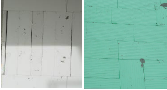
Şekil 16. Şaşırtmacalı olarak monte edilmeyen levha örnekleri
