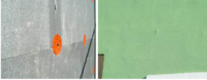
Şekil 18. Yanlış uzunlukta matkap ucu kullanılması
