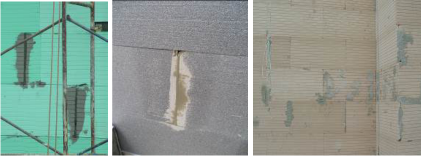
Şekil 17. Levha birleşimlerinde ki boşlukların harç ile doldurulmuş yanlış örnekler
