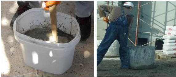
Şekil 11. Yanlış karıştırma metotları
