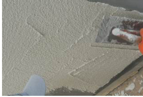
Şekil 23. Kalın dekoratif kaplama yapılması örneği,
