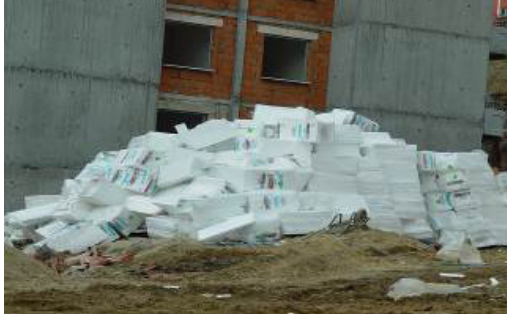
Şekil 25. Hatalı stoklama
