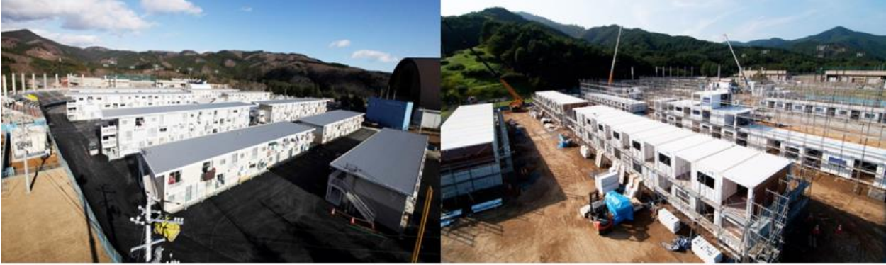
Şekil 19. Onagawa Konteyner Konut Projesi Uygulaması 'Cargotecture'
