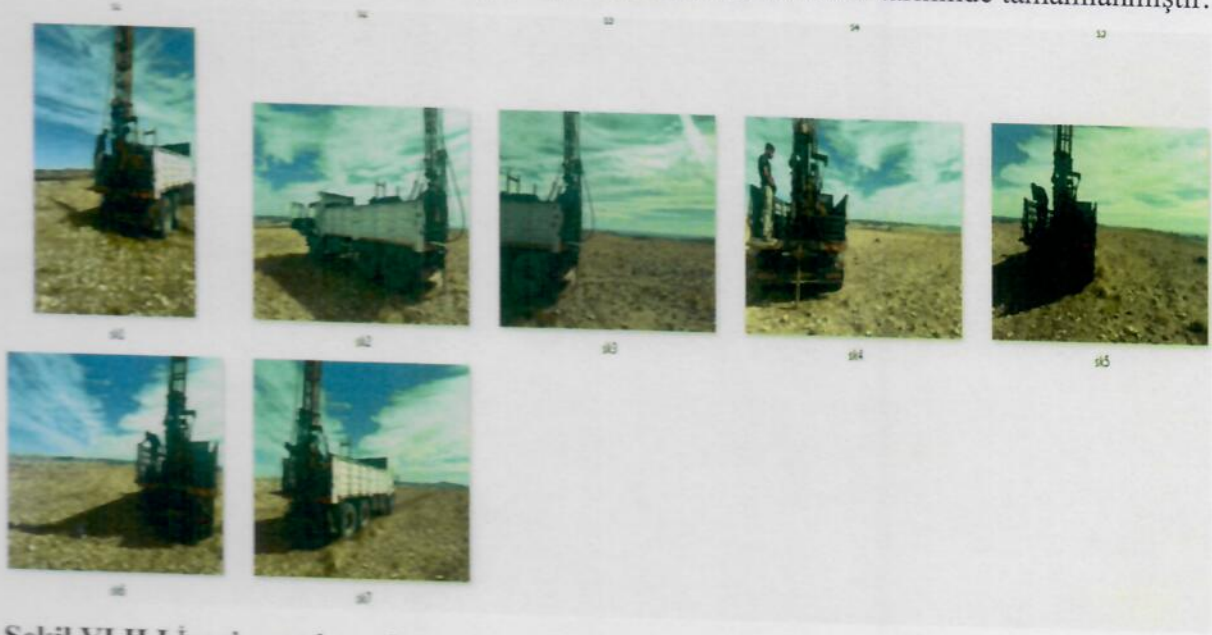
Şekil VI.II.I İnceleme alanında yapılan jeoteknik sondaj çalışmalarından görüntüler.
