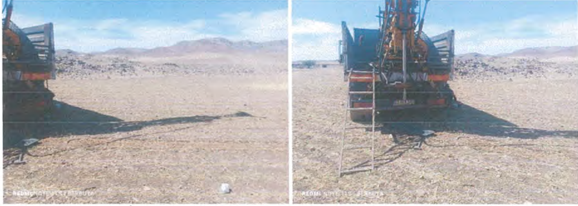
Şekil 6.1. İnceleme Alanında Yapılan Sondaj Çalışmalarından Görünüm
