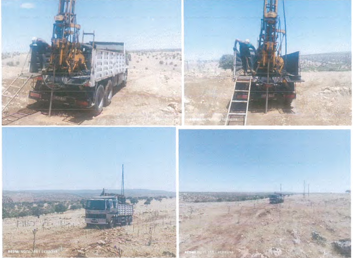
Şekil 6.1. İnceleme Alanında Yapılan Sondaj Çalışmalarından Görünüm
