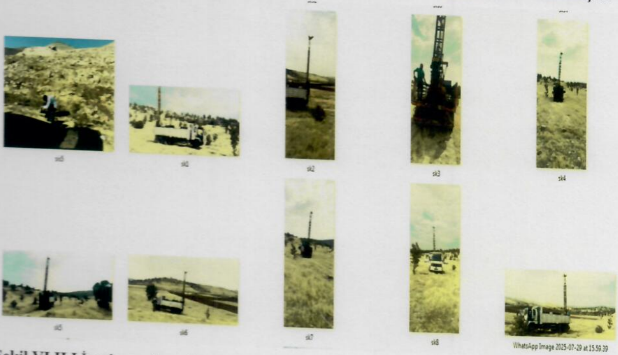
Şekil VI.II.I İnceleme alanında yapılan jeoteknik sondaj çalışmasından görüntüler.
