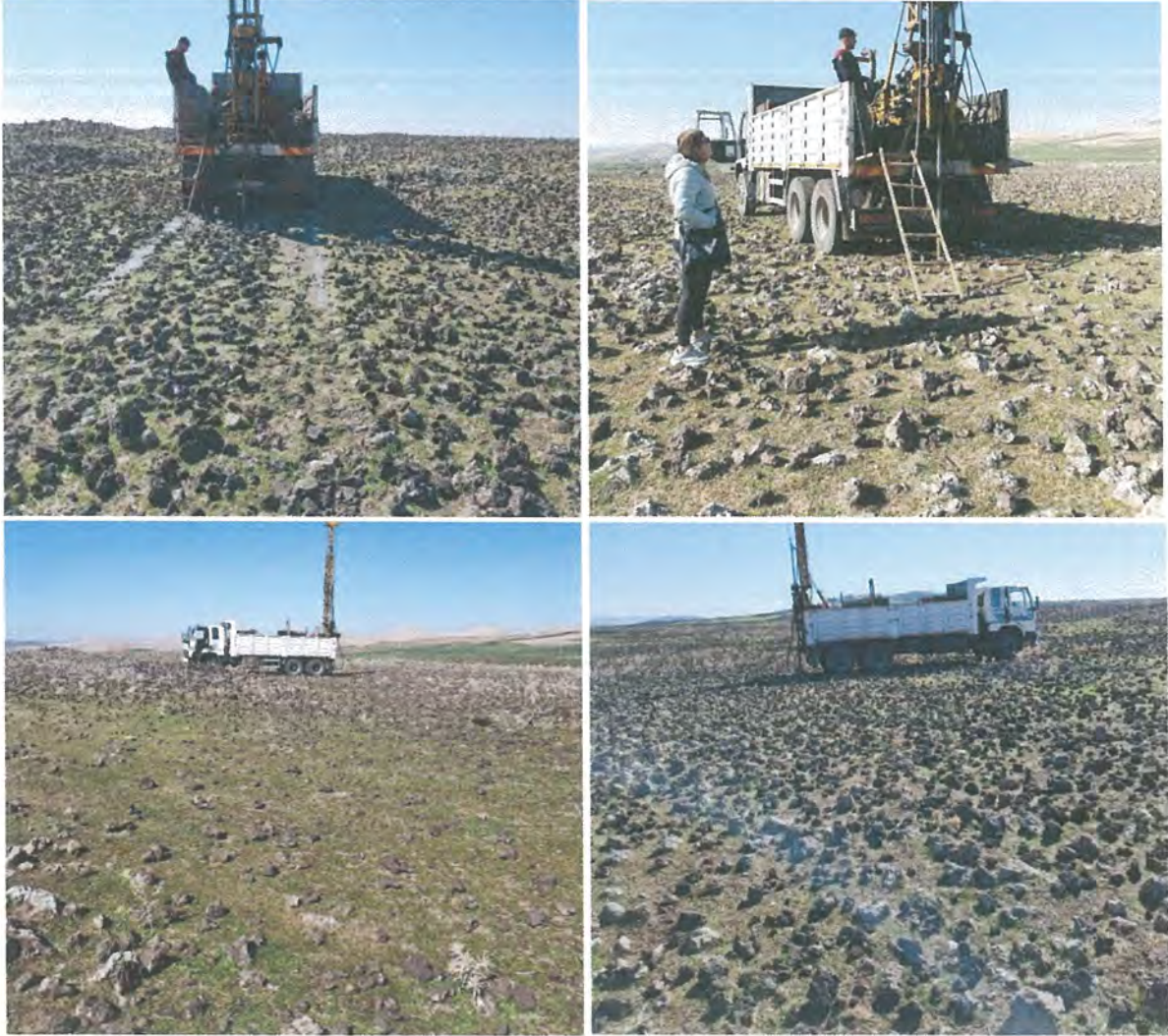
Şekil 6.1. İnceleme Alanında Yapılan Sondaj Çalışmalarından Görünüm
