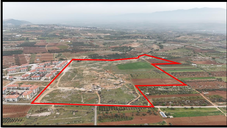
Şekil 12 Planlama Alanından Görünüm
