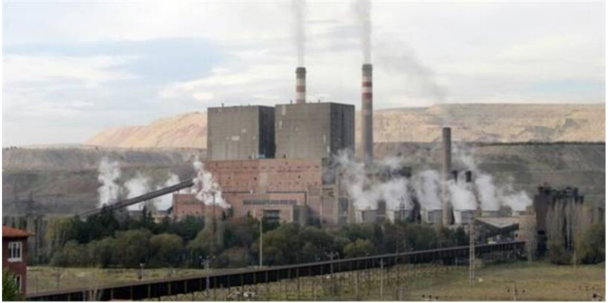
Resim 3: Çelikler Tunçbilek Termik Santrali
