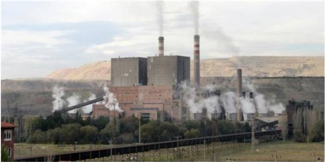
Resim 11: Çelikler Tunçbilek Termik Santrali
