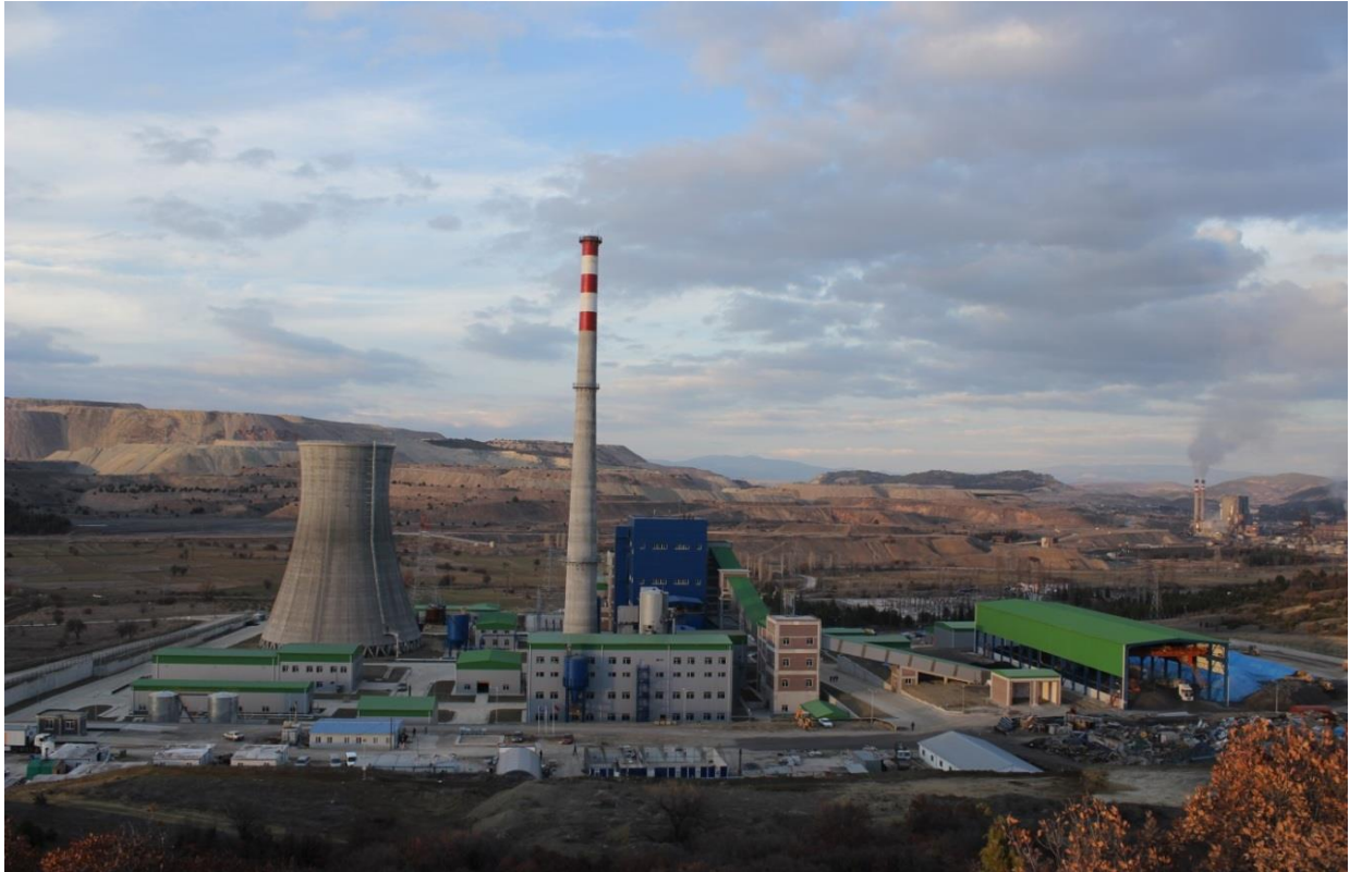
Resim 9: Polat Termik Santrali
