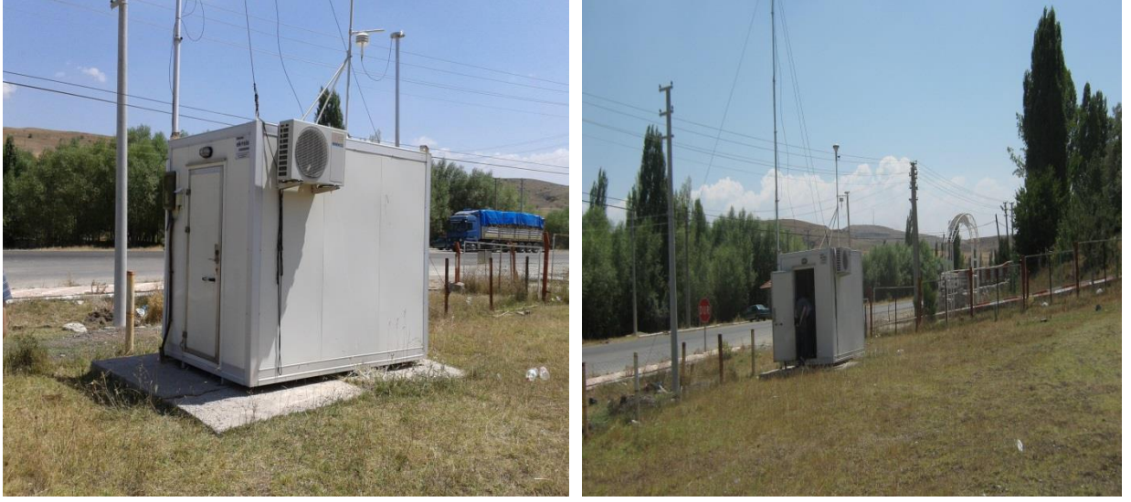
Şekil 12: EÜAŞ Seyitömer Termik Santrali (Jandarma yanı) hava kalitesi ölçüm istasyonu
