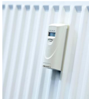
Şekil 4. Isı Pay Ölçer Montajı
