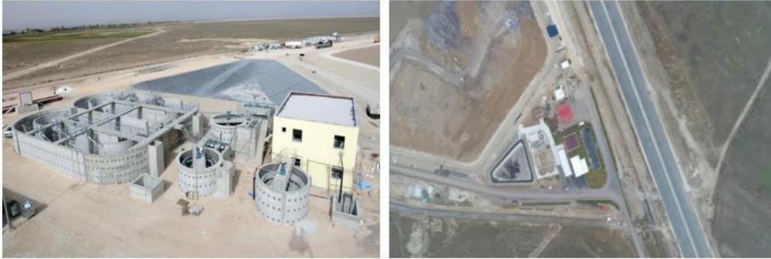
Şekil 1:Konya Katı Atık Düzenli Depolama Sahası
