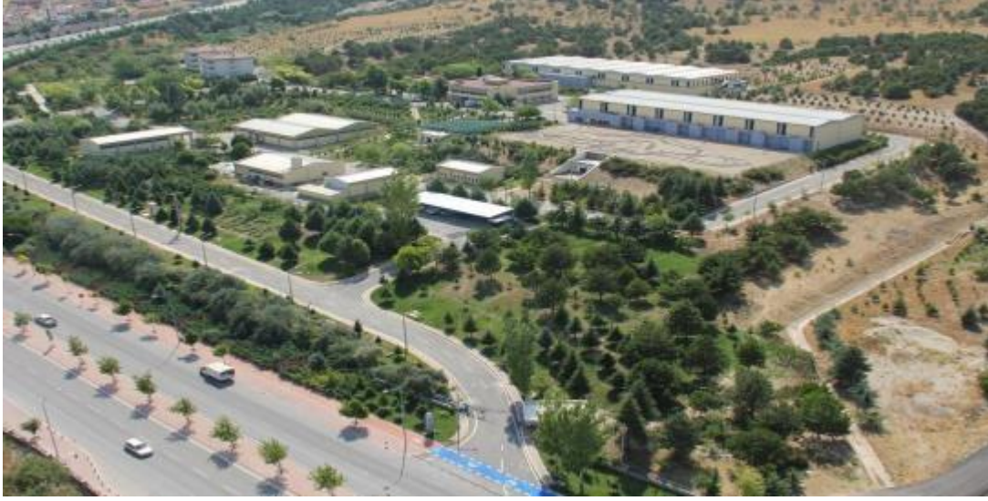
Şekil 3: Akyokuş İçme Suyu Arıtma Tesisi
