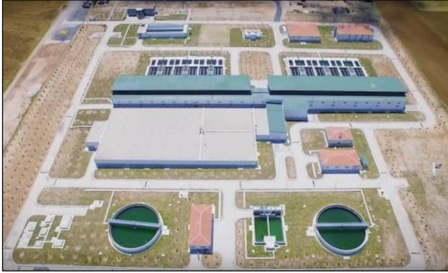
Şekil 2:Seçme İçme Suyu Arıtma Tesisi
