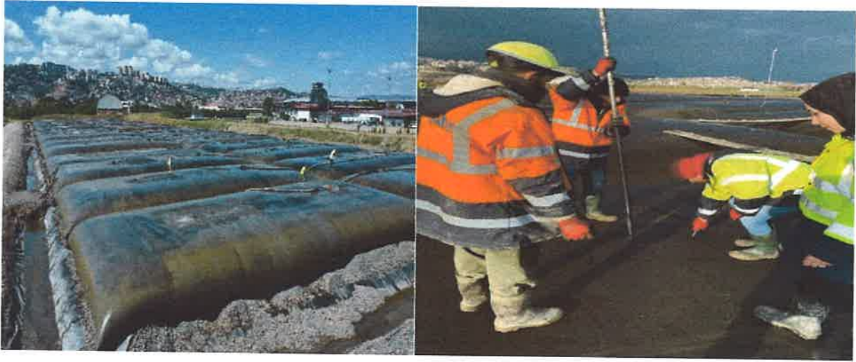
Şekil 8: Dip Çamuru Temizleme Çalışmaları
