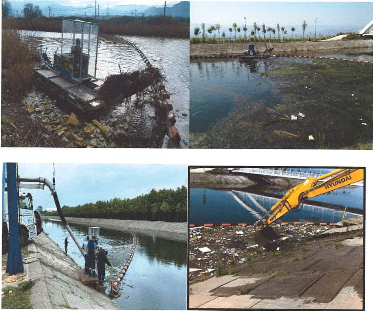
Şekil 6: Bariyer Temizleme Çalışmaları
