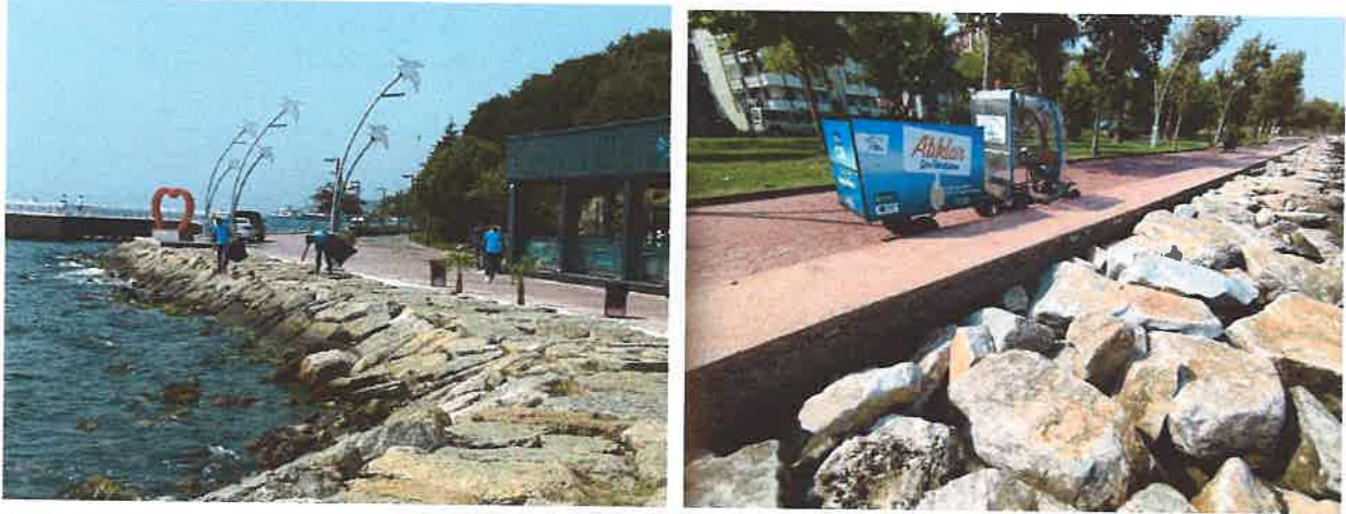
Şekil 37: Kocaeli İli Yürüyüş Yolunda Yapılan Temizlik Çalışması
