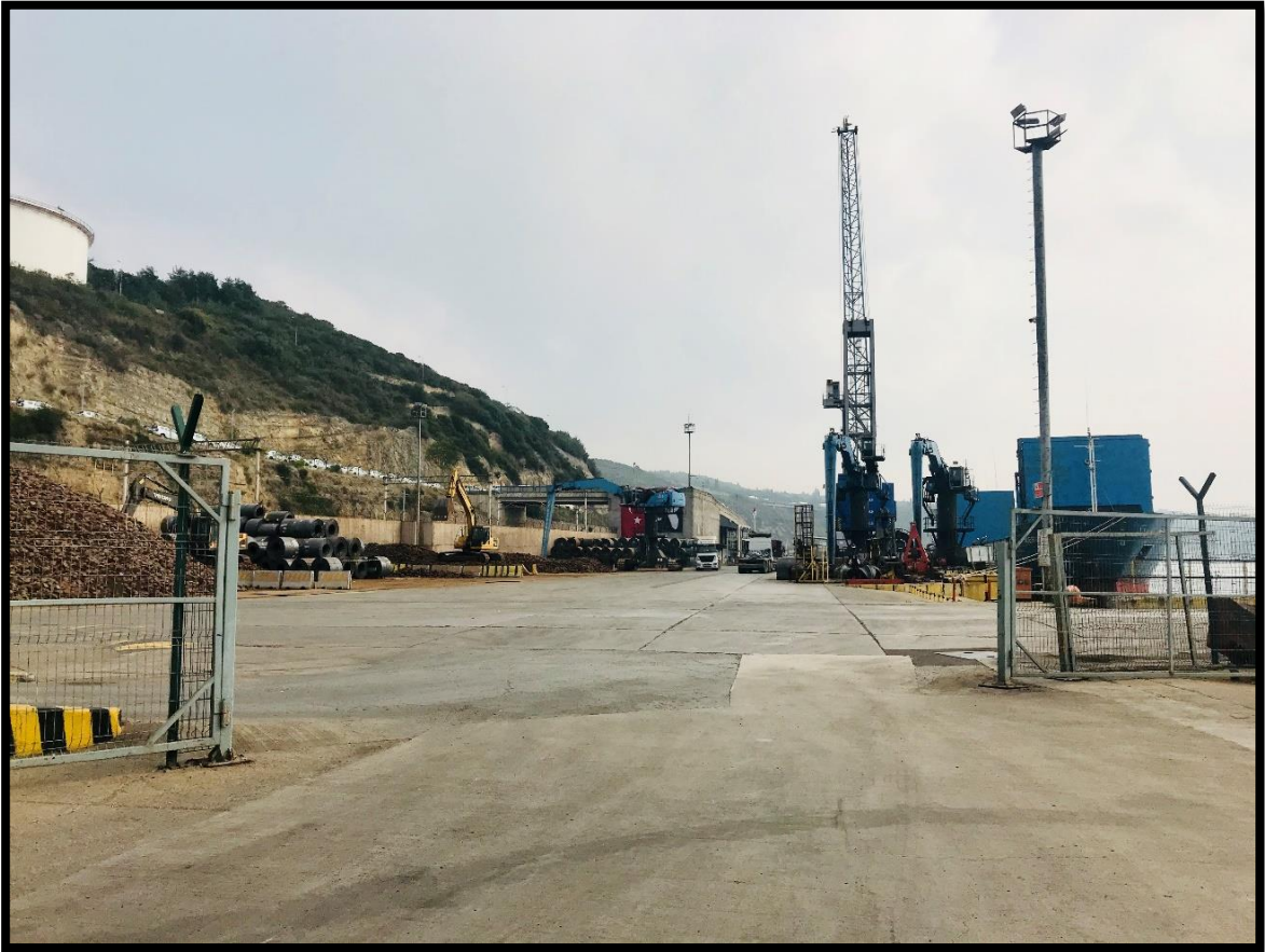
Fotoğraf 5: Efesanport Liman Tesisi Giriş Kapısı
