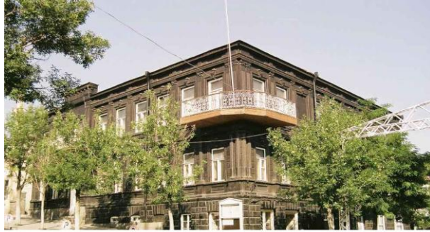
Resim 4:Eski Belediye Binası
