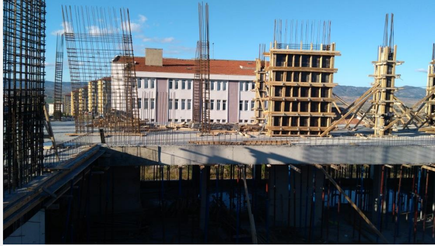
Kastamonu 15 Temmuz 24 Derslikli Okul Binası Yapım İşi
